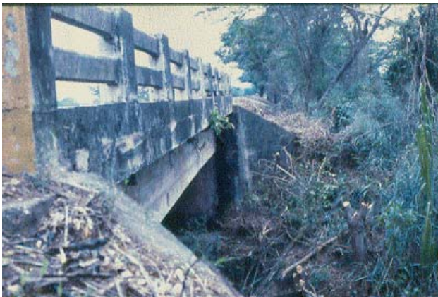
Figura 7. Puente de concreto.
