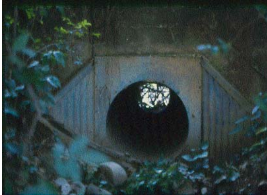
Figura 5. Alcantarilla en buen estado físico.
