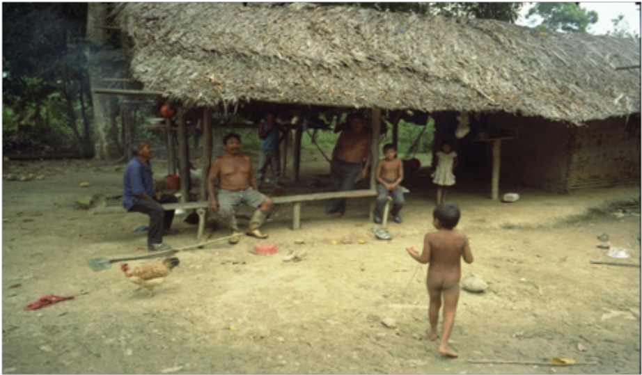
Figura 9: Vivienda Warao de construcción mixta, paredes de bahareque y horcones clavados en tierra en el Alto Delta. Remansón, caño Cocuina. Foto: Alvaro García-Castro.
