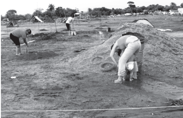
Mujeres en plena jornada en la autoconstrucción de sus propias viviendas.
