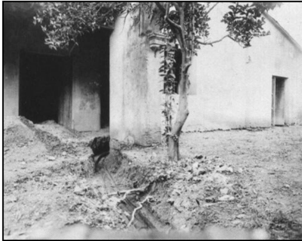
Lámina 1. Cañería de tubos de barro, hallada durante las obras de reconstrucción realizadas dirigidas por vicente Lecuna. (Duarte 2003: 60)
