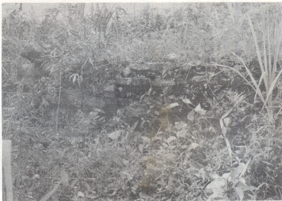
MURO DE CONTENCIÓN DEL CAMINO DE ACCESO AL YA- CIMIENTO.
