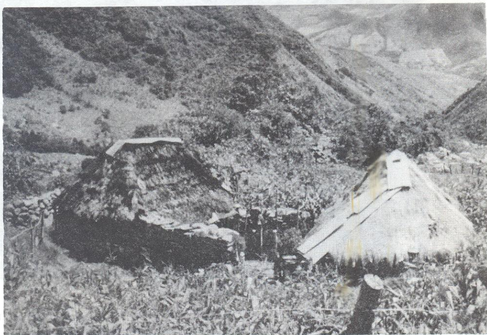
Casas actuales de piedras, de construcción indígena, con zinc incorporado. Esca- güey, Mérida, Foto J.L. Quinte- ro, Proy. H-119, Museo Arqueo- lógico, 1988.
