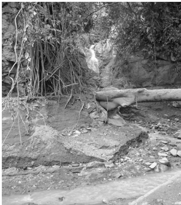
Fig. 5. Sector el Diamante, norte de Santa Cruz de Mora, nótase el nivel de represamiento de las aguas por sedimentos y troncos. Foto Cortesía Jaime Laffaille. FUNDAPRIS. ULA. Fac. de Ciencias
