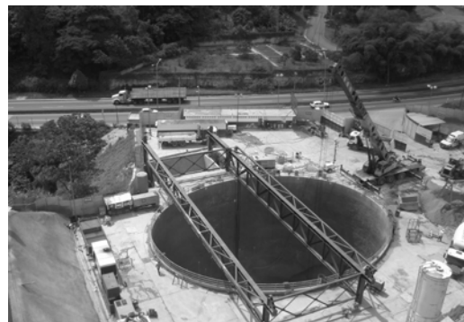
Fig. 3. Distribución de equipos en el Frente. Fase I: excavación y túnel minero.
