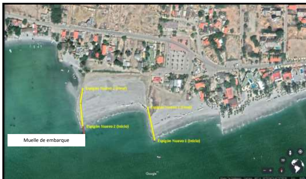
FIGURA 1. Posición relativa de espigones de piedra construidos en el año 2012. Fuente: Google Earth, imagen satelital 2019.
