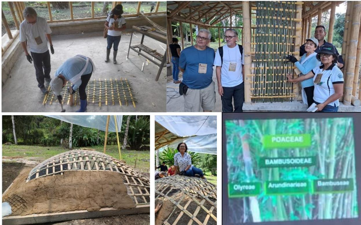
**FIGURA 10.** Registro de las diferentes actividades realizadas en Taller de Construcción con Bambú y Tierra - Técnica DOMOCAÑA. Se denota la resistencia de las tiras de los culmos o cañas, que al ser entretejidas por la unión de elementos galvanizados y alcanzar su forma curva, aumenta su resistencia a las fuerzas de compresión tal como se muestra la suspensión de la autora sobre la el domo.
