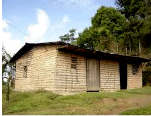
FIGURA 8. Casas tradicionales de Bahareque en construcción.
