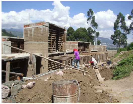
FIGURA 10. Combinación de sistemas constructivos: Tapia, Piedra y Adobe (izq.) y Adobe y Bahareque (der.)
