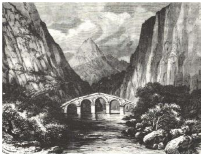
Figura N° 2. Vía Popayán – Pasto. Puente de Juanambú
