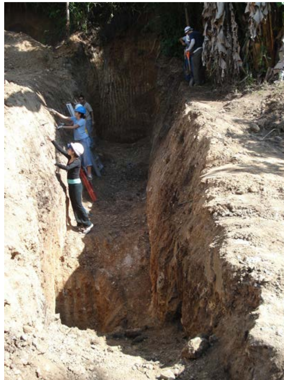
Figura 6. Limpieza de las paredes de la excavación, previo al levantamiento geológico de las mismas. Foto: Rodríguez, 2008
