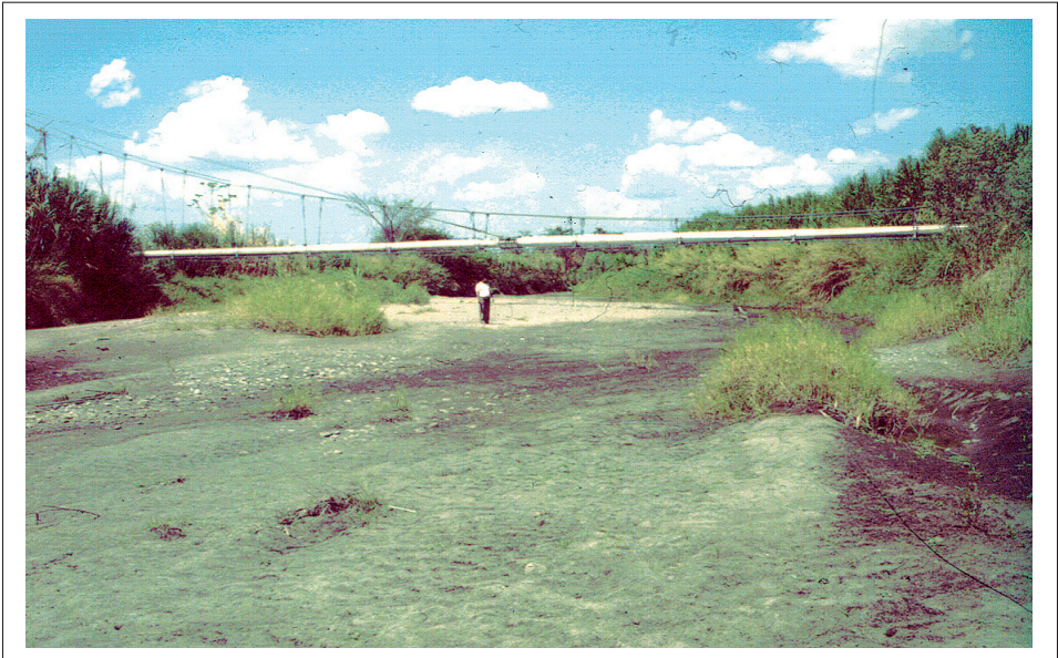
Figura 9. Vista parcial del paso del río Guanare tomada aguas arriba
