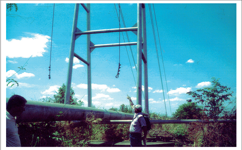
Figura 10. Uno de los problemas más graves para la seguridad de la estructura colgante lo constituye la continua sustracción de elementos claves para la estabilidad de la misma
