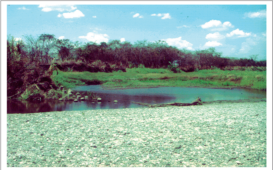
Figura 7.- La colocación de tetrápodos con fines de protección contra la erosión de las riberas parece haber inducido cambios en la conducta hidráulica del río en esta sección; ello justificó su reemplazo y redistribución en otras áreas cercanas del cauce. Vista tomada aguas arriba del sitio de cruce
