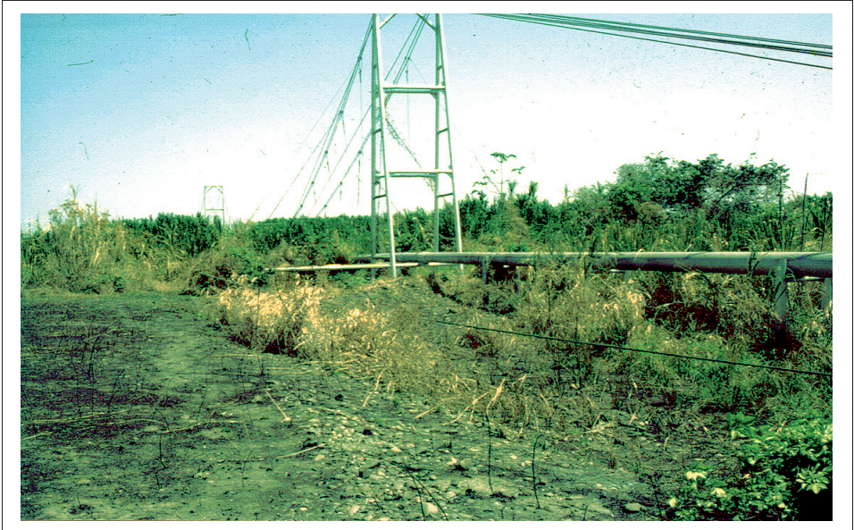
Figura 6. Vista del puente colgante y la sección correspondiente del oleoducto; el petróleo fluye de derecha a izquierda en la fotografía
