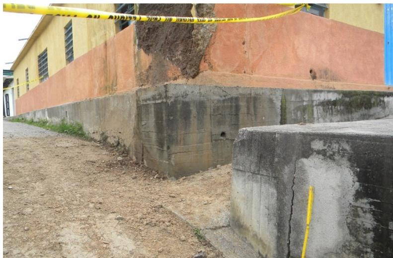
FIGURA 6. Desplazamientos, y deformaciones en el área de estudio
