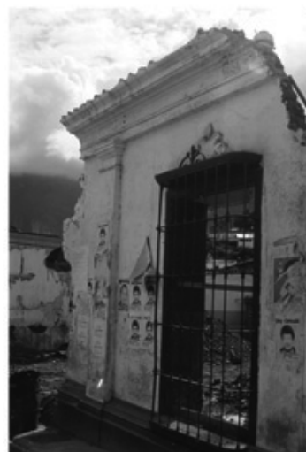
Casa Urdaneta durante su demolición, M.García.
